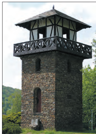
Відновлена римська сторожова вежа, що входила в лімес
