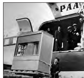
Так виглядав перший жорсткий диск. Його ємність становила лише 5 мегабайт
